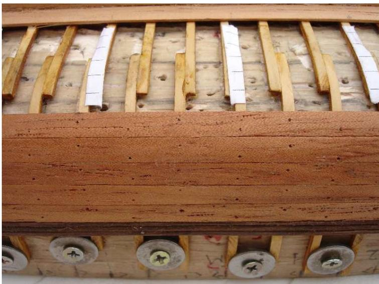
Comencé por colocar la traca de aparadura y luego forré a partir de las cintas. En la foto siguiente se observa el estado de avance; El papel pegado lo utilicé en lugar de las marcas a lápiz, me resultaba más preciso; lo que interesa: recordar ir marcando los agujeros donde irá la clavazón, traca por traca, para hacerla coincidir exactamente con la ubicación de la cuaderna correspondiente.
